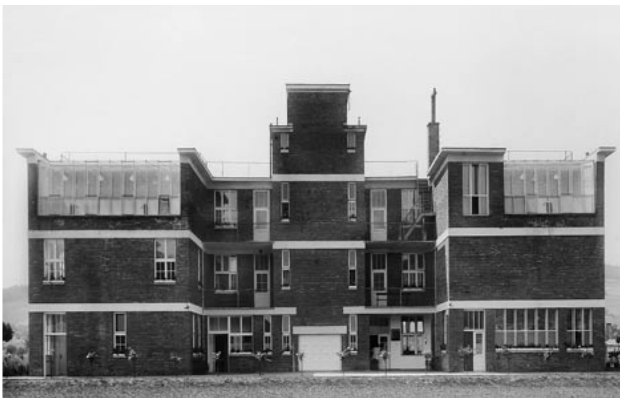
Vstupní budova Bařovy nemocnice, Zlín 1927, zadní pohled
