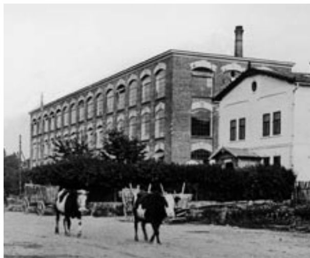
První tovární budova, r. 1905, fotografie od Jana Horáka z r. 1911
