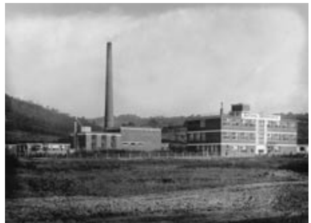
Kotelna a vstupní budova BN
